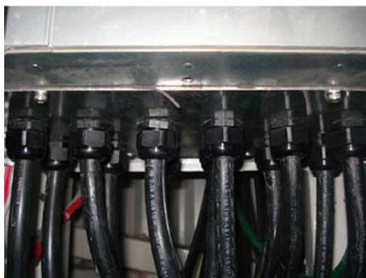
Afbeelding 5.16: Voorbeeld van juiste installatie van de doorvoerplaat.
